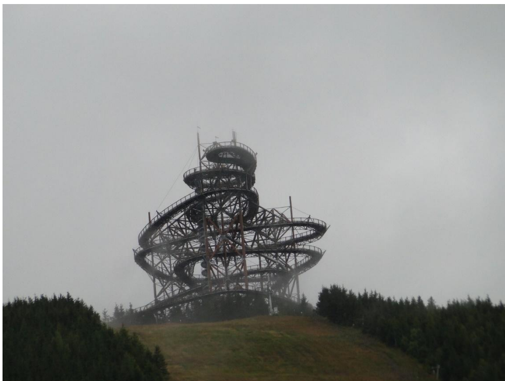
Wieża „Ścieżka w obłokach”
