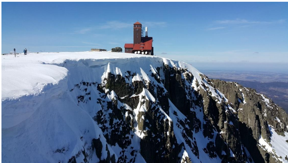
Stacja przekaźnikowa na Śnieżnych Kottach
