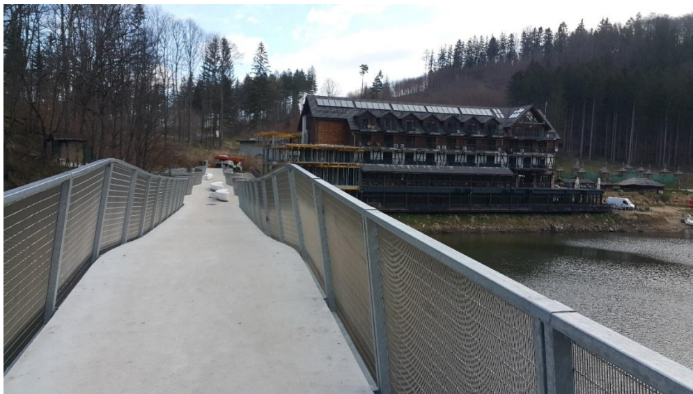
Nowa kładka nad Jeziorem Bystrzyckim
