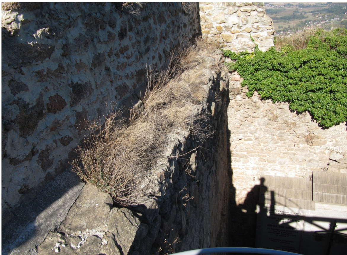
Fot. 3. Odsadzka muru zachodniego.
