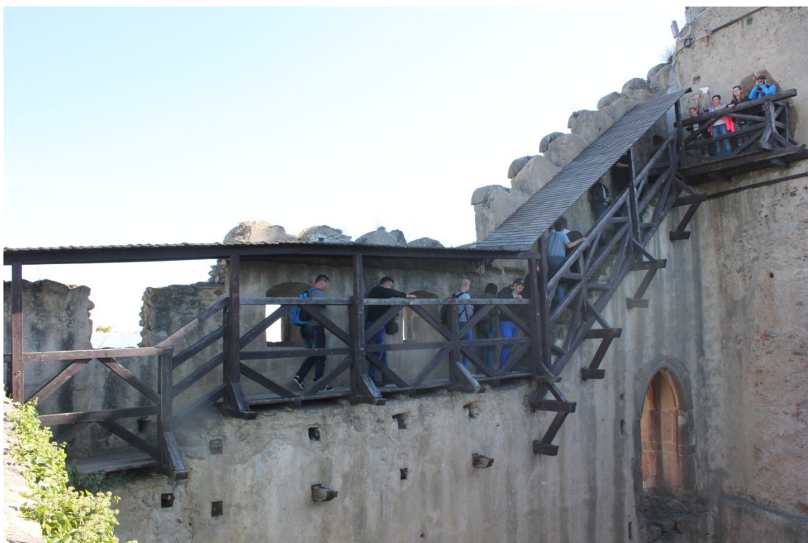
Fot. 4. Mur wschodni.
