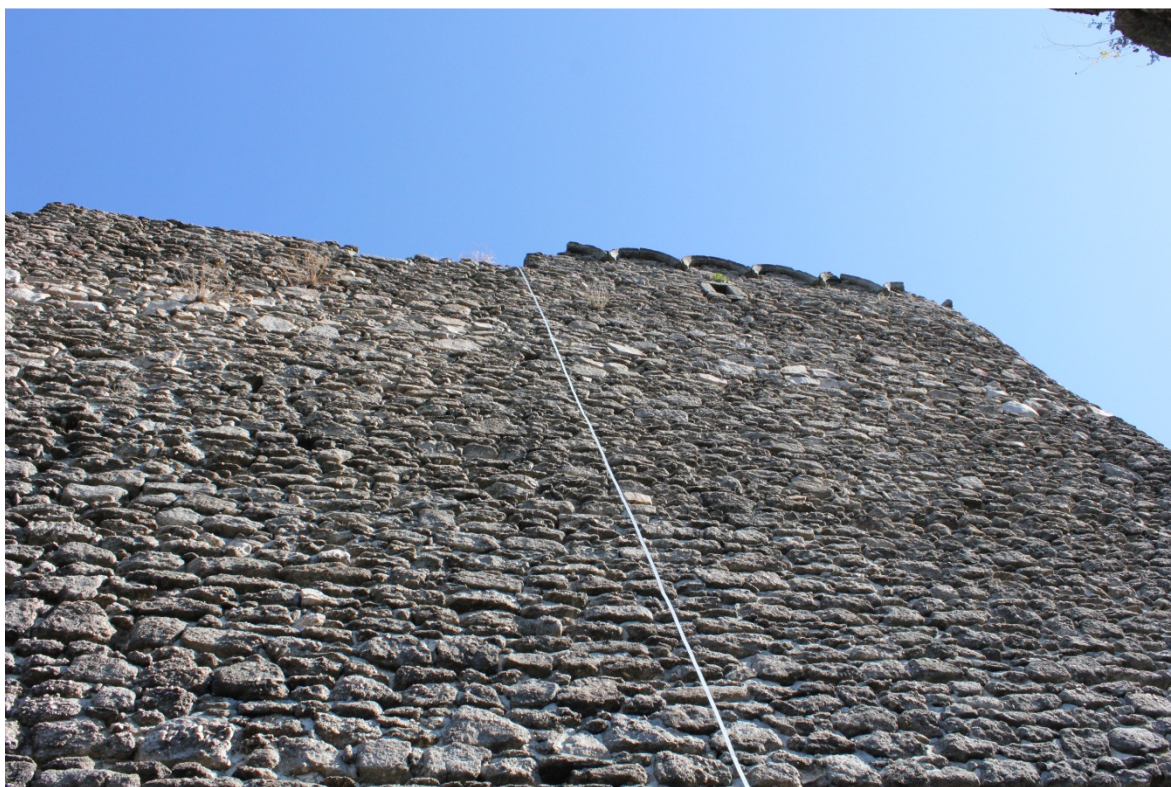
Fot. 10. Mur zachodni.
