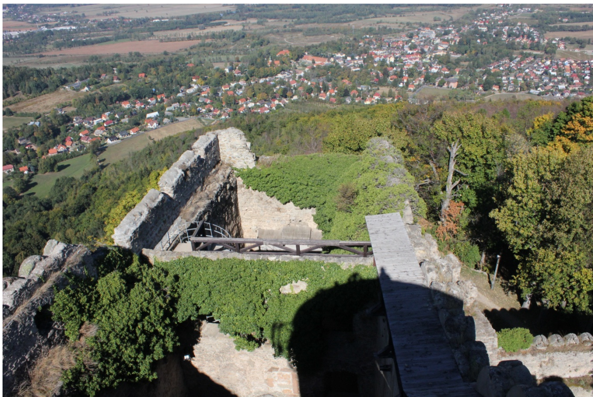
Fot. 1. Widok ogólny korony murów pallacium
