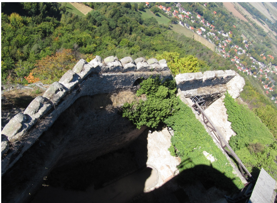
Fot. 5. Mur zachodni.
