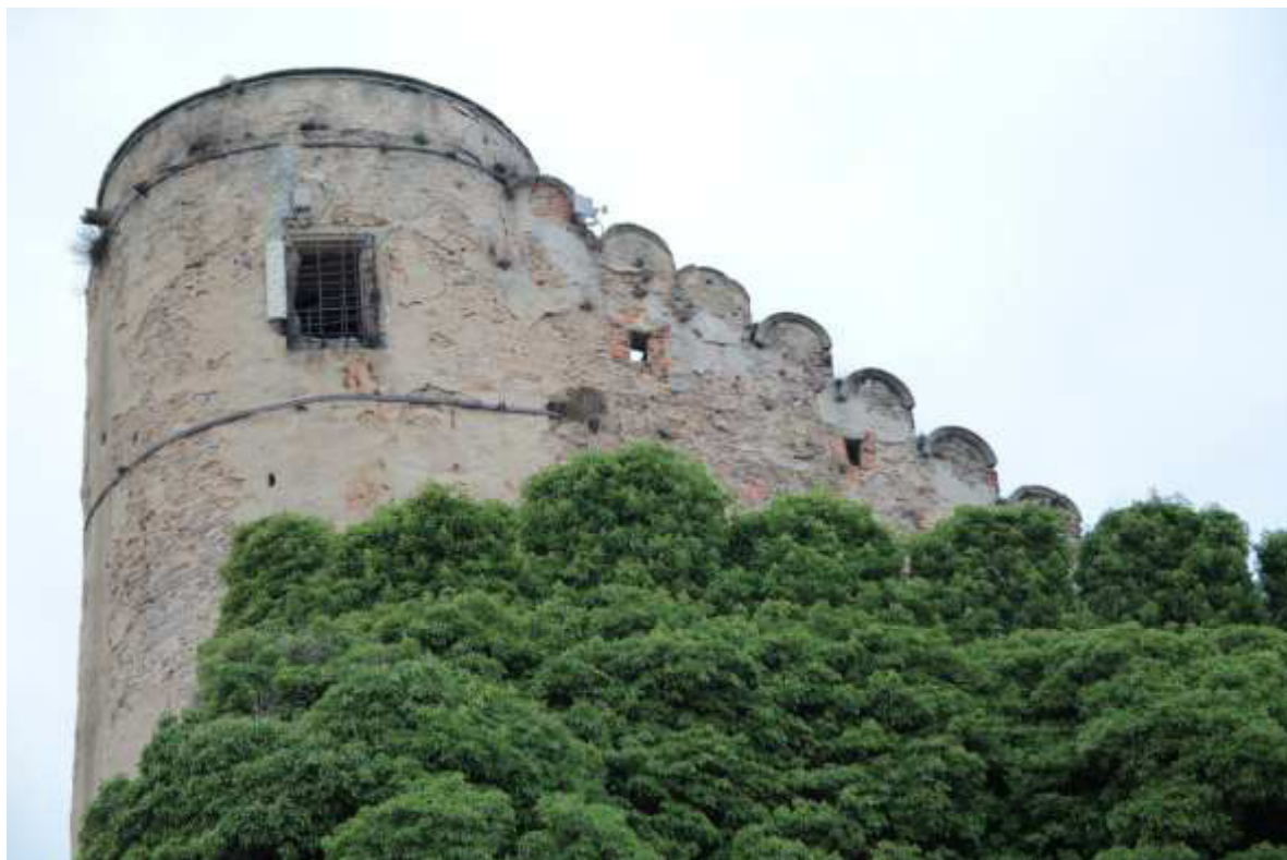
FOT. 1 – Zamek Wysoki, elewacja południowa, fragment, widok ogólny.
