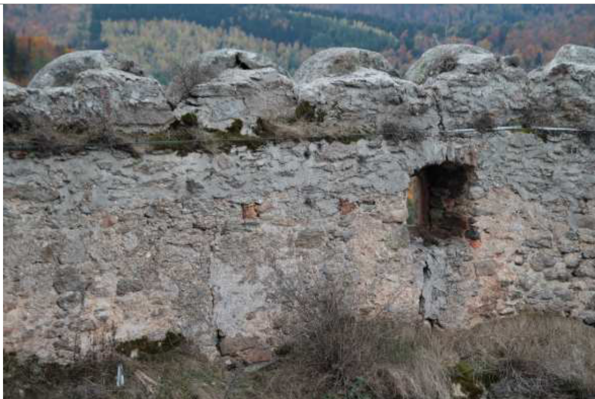
FOT. 16 - Zamek Wysoki, mur południowy, zwieńczenie, fragment. Widok ogólny od strony dziedzińca.
