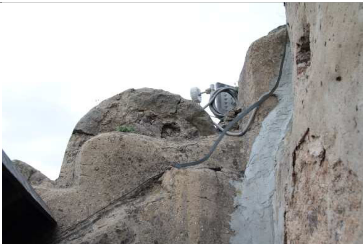
FOT. 29, 30 - Zamek Wysoki, mur północny, zwieńczenie – odcinek krenelażu przy elewacji wieży. Widok od strony elewacji południowej (wyżej) i od strony dziedzińca.
