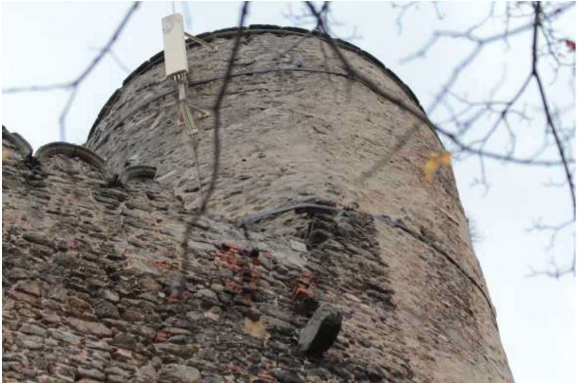
FOT. 7 - Zamek Wysoki, elewacja północna, fragment – zwieńczenie muru południowego, odcinek wschodni.
