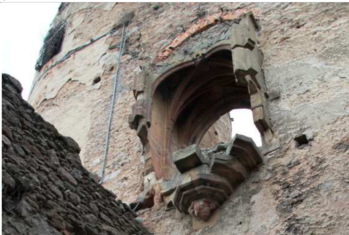
FOT. 42 - Zamek Wysoki, elewacja południowa, fragment – detal profilowanych i rzeźbionych bloków piaskowca wykusza.
