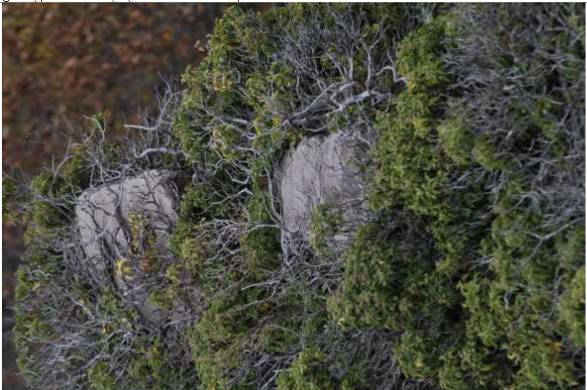
FOT. 34 - Zamek Wysoki, mur północny, zwieńczenie zachodniego odcinka muru, widok ogólny z wieży.
