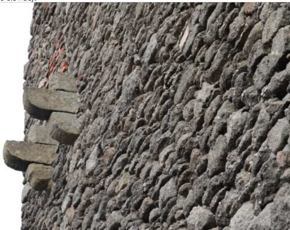
FOT. 38 - Zamek Wysoki, elewacja północna, fragment – detale kamienne elewacji.
