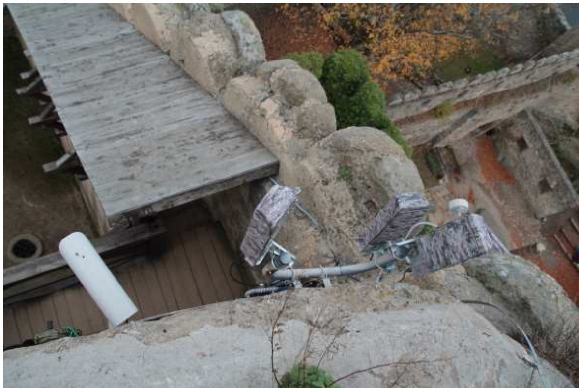
FOT. 25 - Zamek Wysoki, mur północny, zwieńczenie – fragment krenelażu, widok z góry od strony dziedzińca przy wieży.
