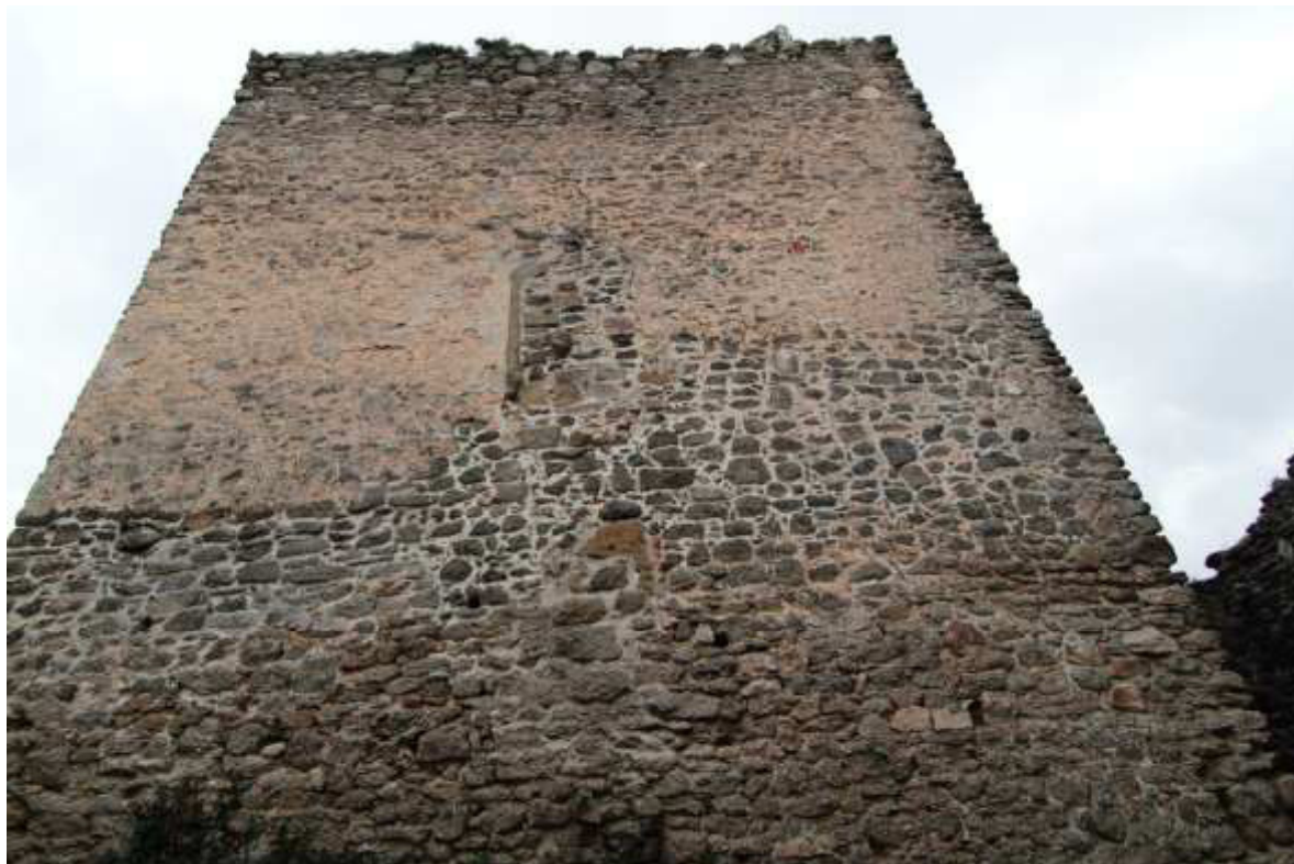
FOT. 37 - Zamek Wysoki, elewacja wschodnia budynku mieszkalnego, widok ogólny – detale kamienne w licu elewacji.
