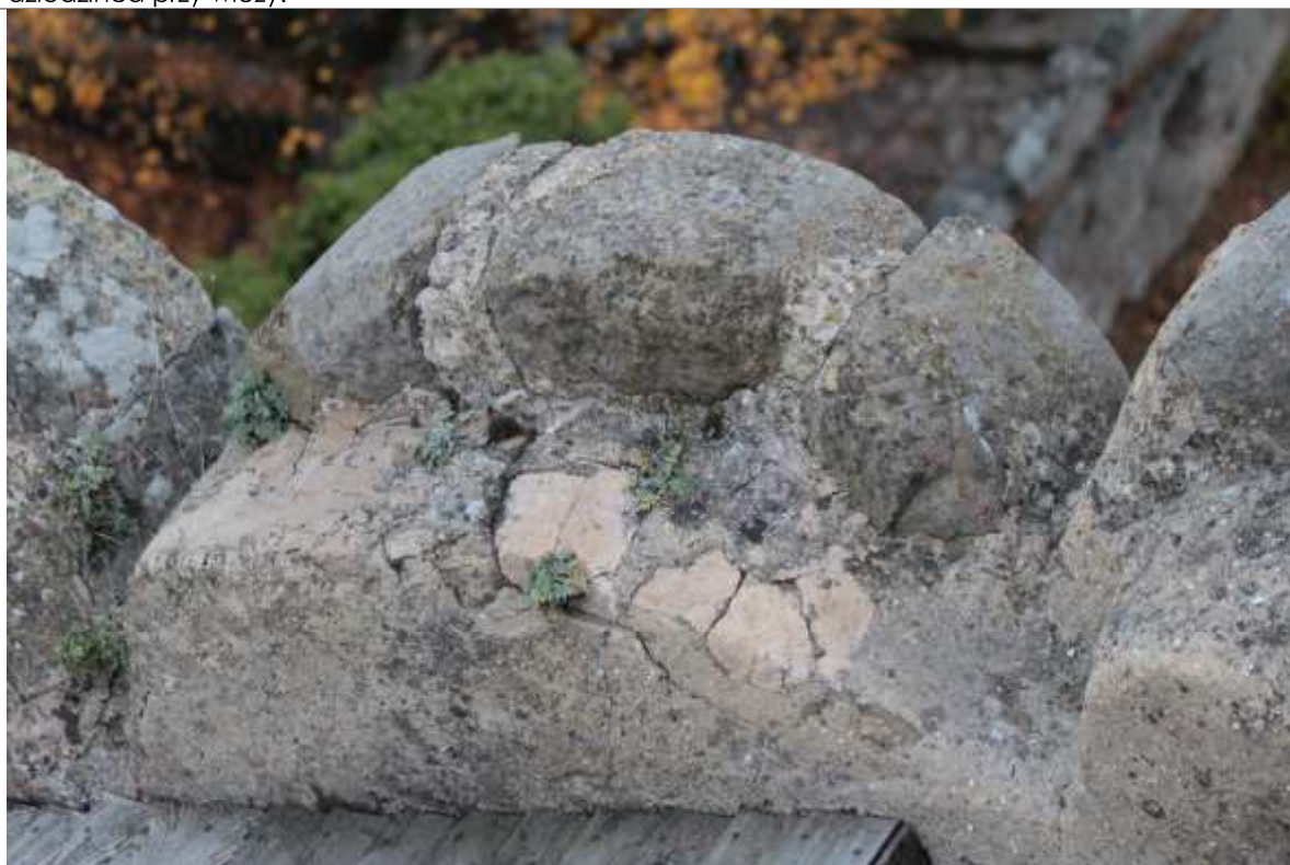
FOT. 26 - Zamek Wysoki, mur północny, zwieńczenie – ząb krenelażu, fragment, detal fot.25
