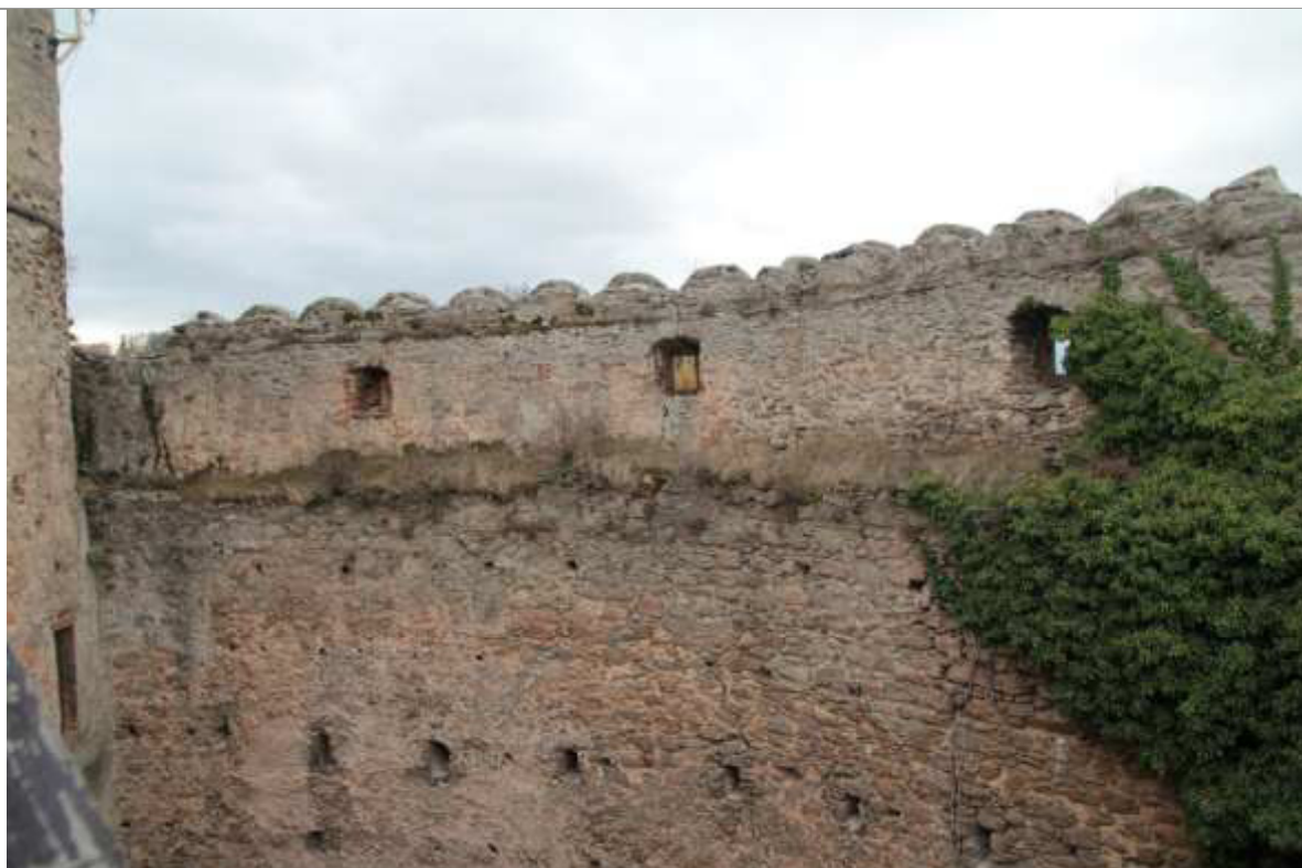
FOT. 6 - Zamek Wysoki, mur południowy, zwieńczenie. Widok ogólny od strony dziedzińca.
