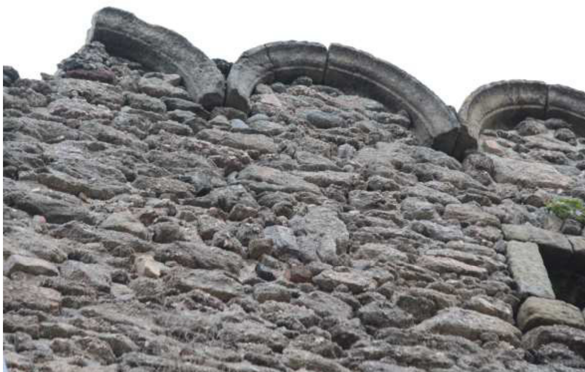
FOT. 9, 10 - Zamek Wysoki, elewacja północna, fragment – zwieńczenie muru południowego w odcinku wschodnim.
