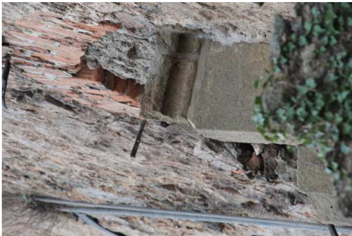
FOT. 41 - Zamek Wysoki, elewacja południowa, fragment – detale kamienne w licu elewacji.
