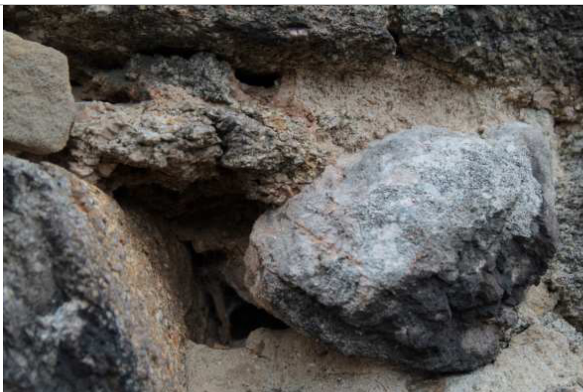
FOT. 35, 36 - Zamek Wysoki, mur budowli, fragment- stan zachowania budulca, przykłady
