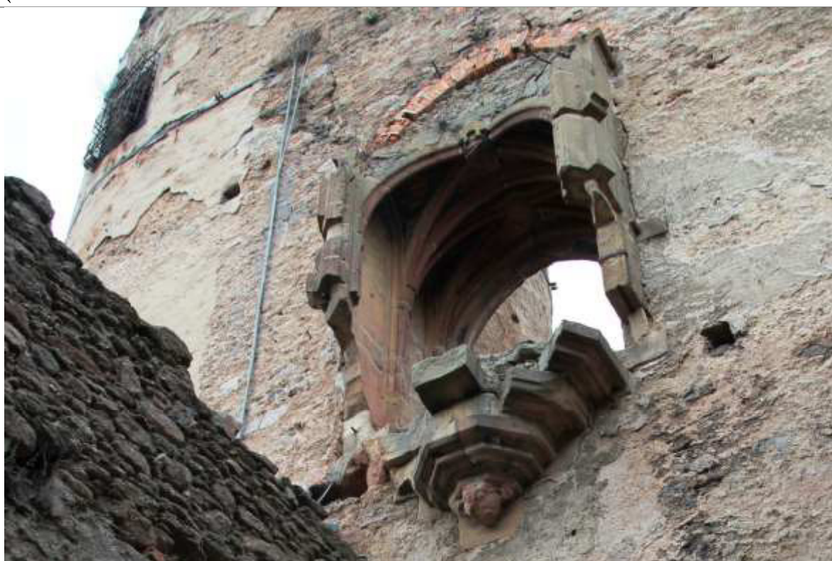
FOT. 42 - Zamek Wysoki, elewacja południowa, fragment – detal profilowanych i rzeźbionych bloków piaskowca wykusza.
