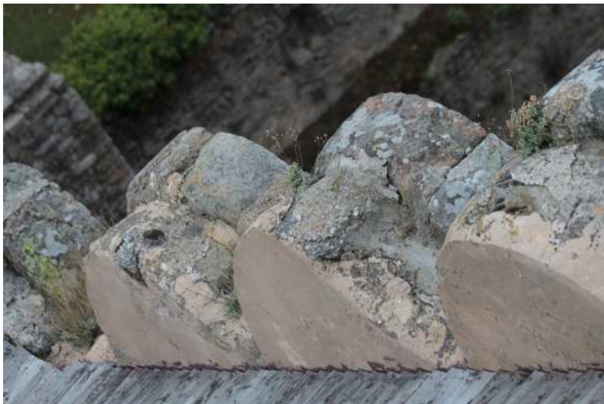
FOT. 27 - Zamek Wysoki, mur północny, zwieńczenie – odcinek krenelażu, widok z wieży.
