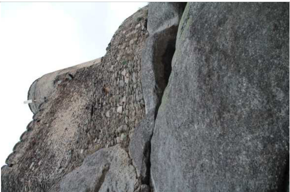
FOT. 4 - Zamek Wysoki, elewacja północna – widok ogólny.
