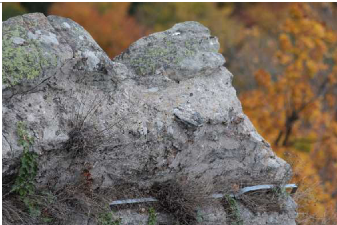
FOT. 17, 18 - Zamek Wysoki, mur południowy, zwieńczenie – końcowy, zachodni odcinek krenelażu Widok ogólny od strony dziedzińca i fragment.
