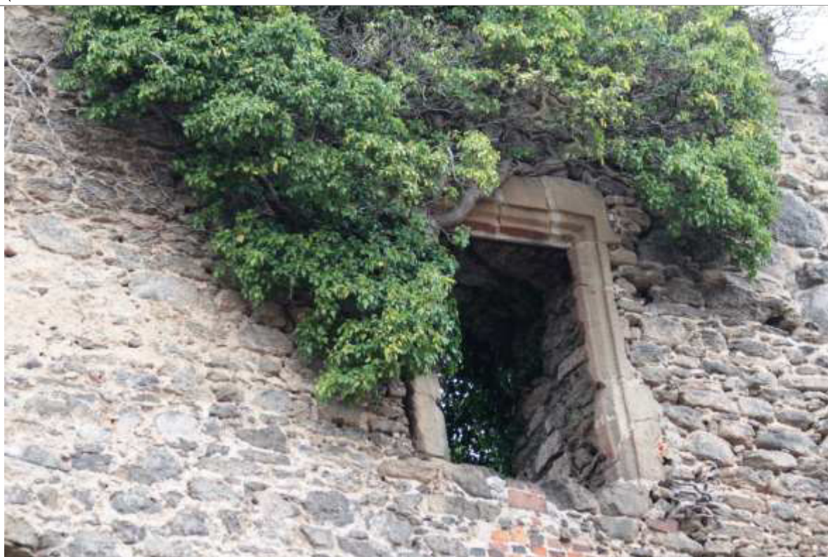
FOT. 39, 40 - Zamek Wysoki, elewacja południowa, fragment – detale kamienne w licu elewacji.
