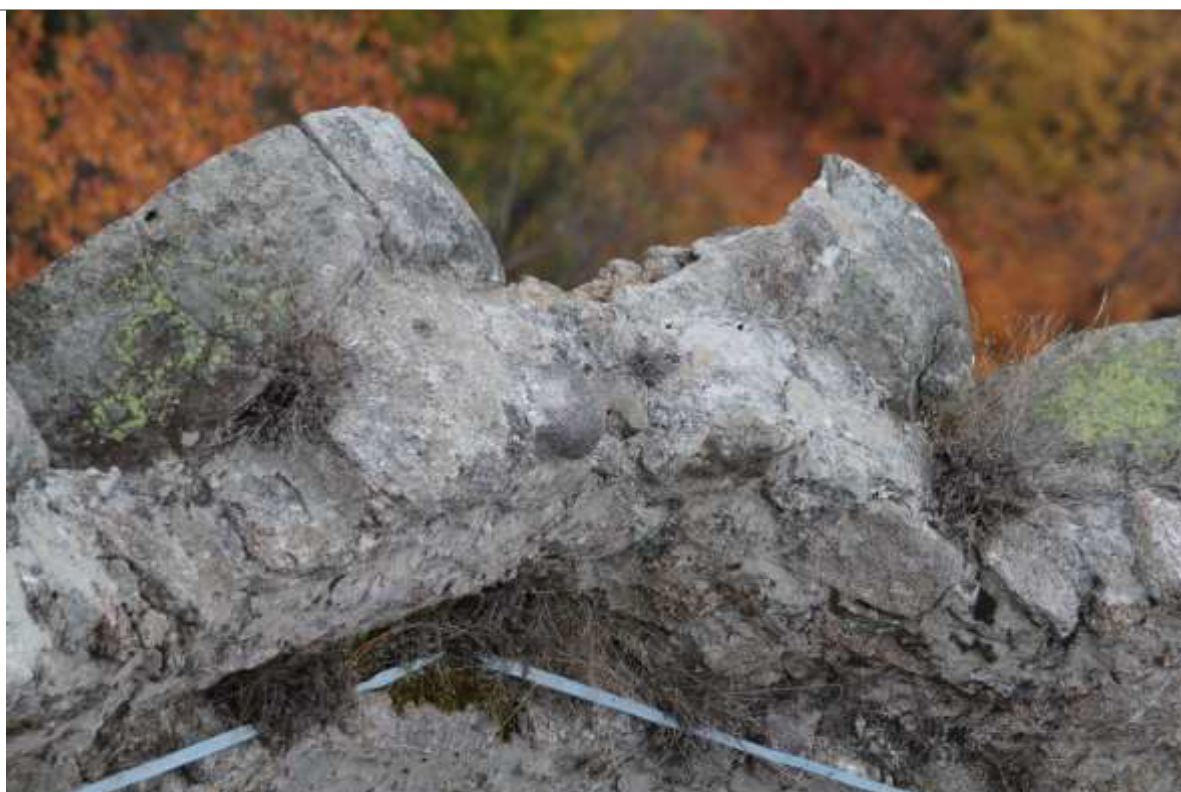
FOT. 11, 12 - Zamek Wysoki, mur południowy, zwieńczenie – fragment krenelażu, widok z góry od strony dziedzińca.
