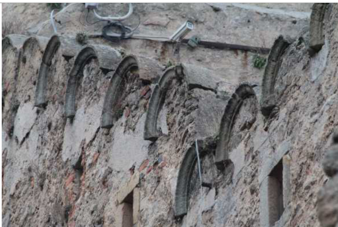
FOT. 21, 22 - Zamek Wysoki, mur północny, elewacja południowa, fragment - widok ogólny na przedpiersie zwieńczenia muru z krenelazem.
